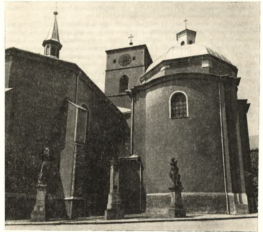
Klimkovice, farní kostel Foto R. Jarnot, 1983
